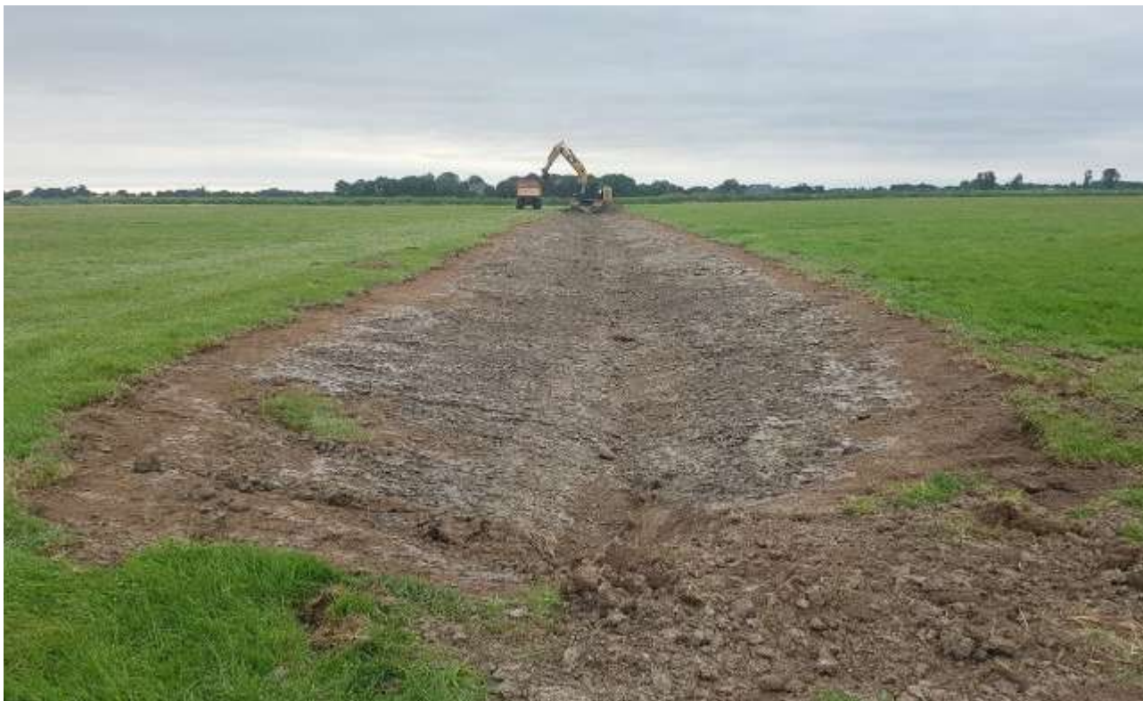
Foto 4-6 - Aanleg brede ondiepe greppel op de locatie van eerder gedempte watergang
